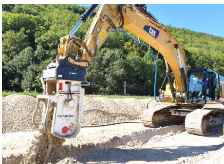
Aufzeichnung, 3D Navigation & Baggersteuerung in einem System!
